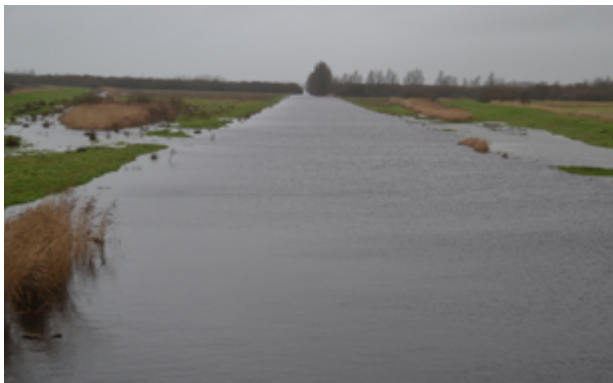
Der absolut volle Polderkanal – fotografiert von der Steinschleuse an der K22 aus Richtung Westerkoog
