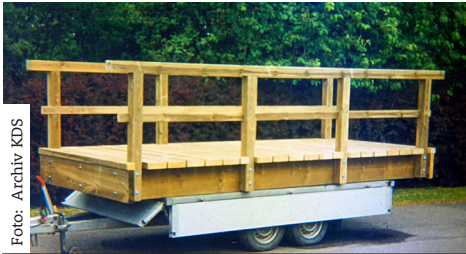
Die Brücke vom Badenkoog in den Naturerlebnisraum fertig zum Aufbau
