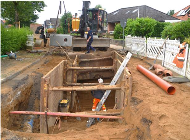
Bis zu 6 m tief wurden die Baugruben ausgehoben. Verlegt wurden Regenwasser- sowie Abwasserkanäle; die Telekom verlegte ihre Leitungen ebenfalls mit. Jan Meeder betonte: „Absolut positiv: Wir sind unter dem Auftragsvolumen geblieben!“ Thomas Holtz unterstrich: „Es war eine technisch sehr anspruchsvolle Leistung! Das, was Arbeit gemacht hat, sieht man nicht!“
